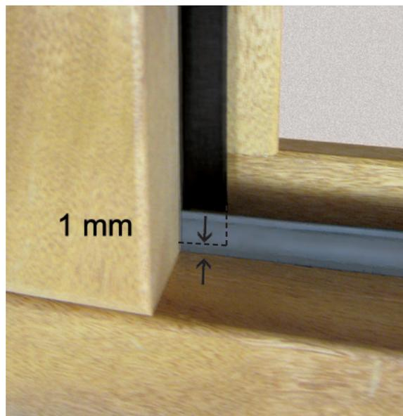
2 - Mettre les joints des montants en rainure
